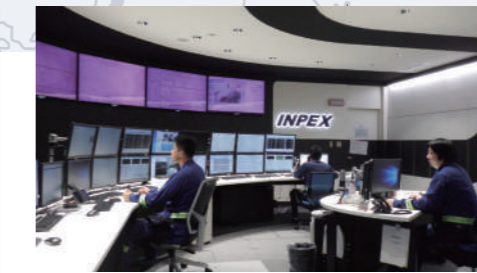
直江津 LNG 基地内
