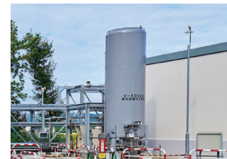
外部から低温(-57℃)の液化炭酸ガス(CO 2 )を受け入れて貯蔵・供給します。
