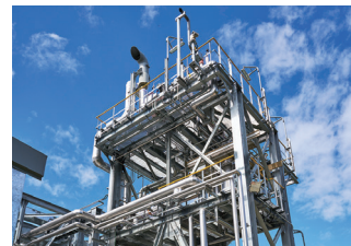
メタネーション反応熱を除去したスチーム(蒸気)を水に戻して回収し、再利用します。
