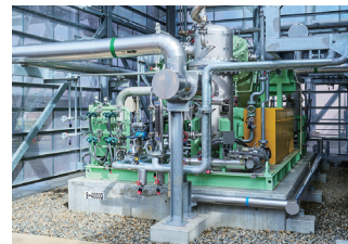
Hから供給される随伴 CO 2 を反応に有利な圧力(1.3 MPaG)まで昇圧します。
