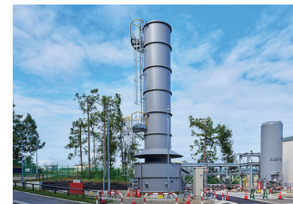
導管注入の条件を満たさないオフスペックの合成メタン等を燃焼処理します。
