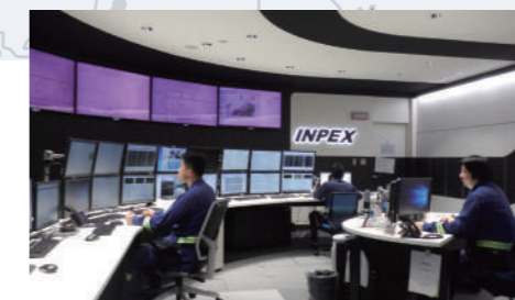
Inside the Naoetsu LNG Terminal
