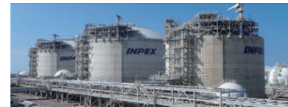
Naoetsu LNG Terminal
