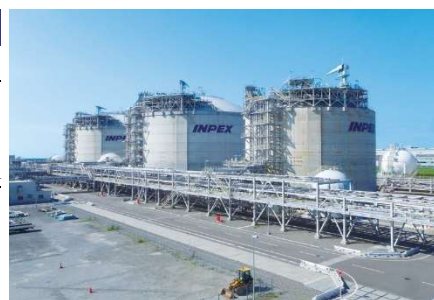
Naoetsu LNG Terminal
