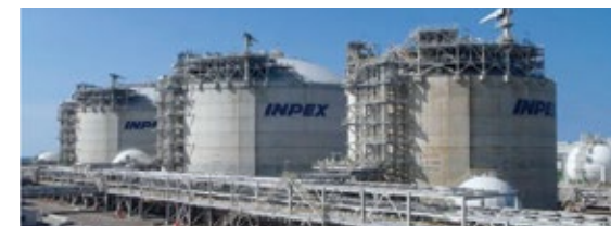
直江津LNG基地
