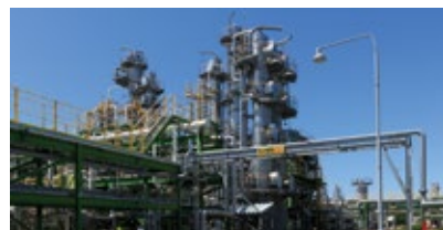
南長岡ガス田(越路原プラント)
