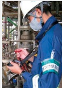
モバイル端末を活用した巡回点検
