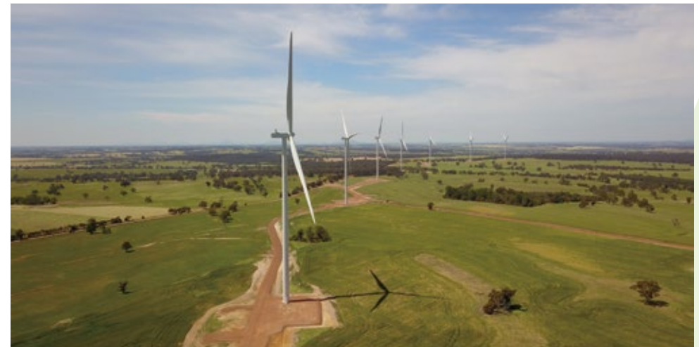
フラットロックス陸上風力発電事業（オーストラリア）
