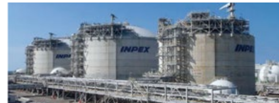
直江津LNG基地
