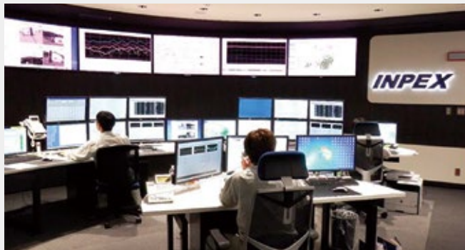
統合オペレーションセンターによる統合監視
