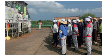
柏崎水素パーク建設現場における コントラクターとの対話
