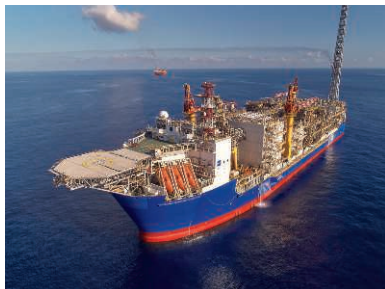
沖合生産・貯油出荷施設(FPSO「イクシスベンチャー」)
