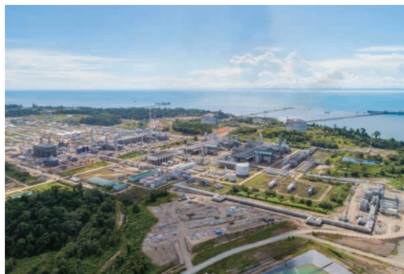
タングーLNGプロジェクト LNG液化プラント
