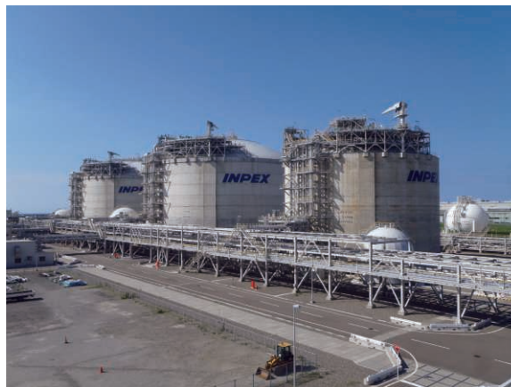
直江津LNG基地
