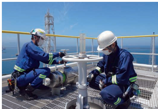
フェイスシールドとマスクを着用しての作業の様子 (直江津LNG基地)
