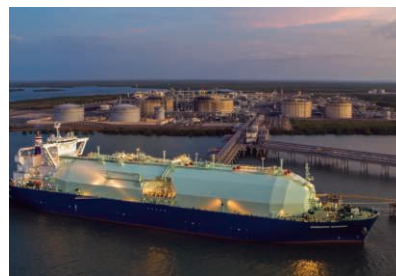
ダーウィンLNGプラントから出航する、LNG船「オセアニック・ブリーズ(OCEANIC BREEZE)」
