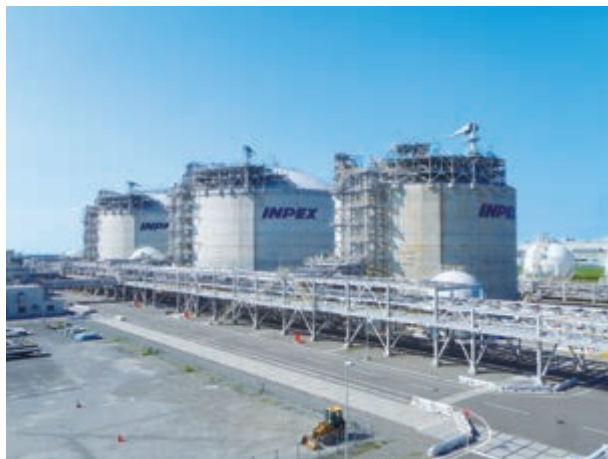
直江津LNG基地
