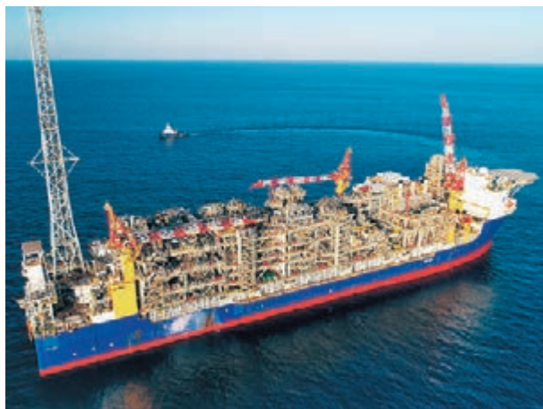
沖合生産・貯油出荷施設(FPSO)
