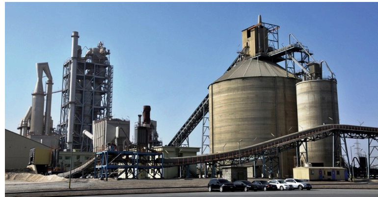
JELにおける掘削屑リサイクル
