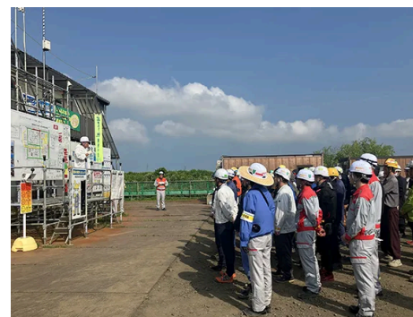
柏崎水素パーク建設現場におけるコントラクターとの対話
