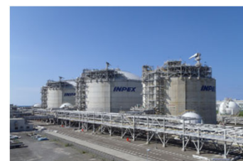
Naoetsu LNG Terminal (Niigata, Japan)
