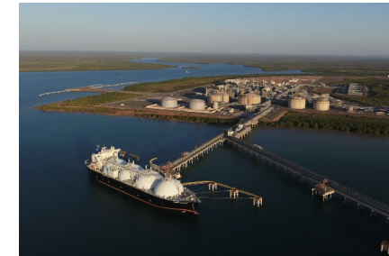
Onshore LNG Plant (Darwin, Australia)
