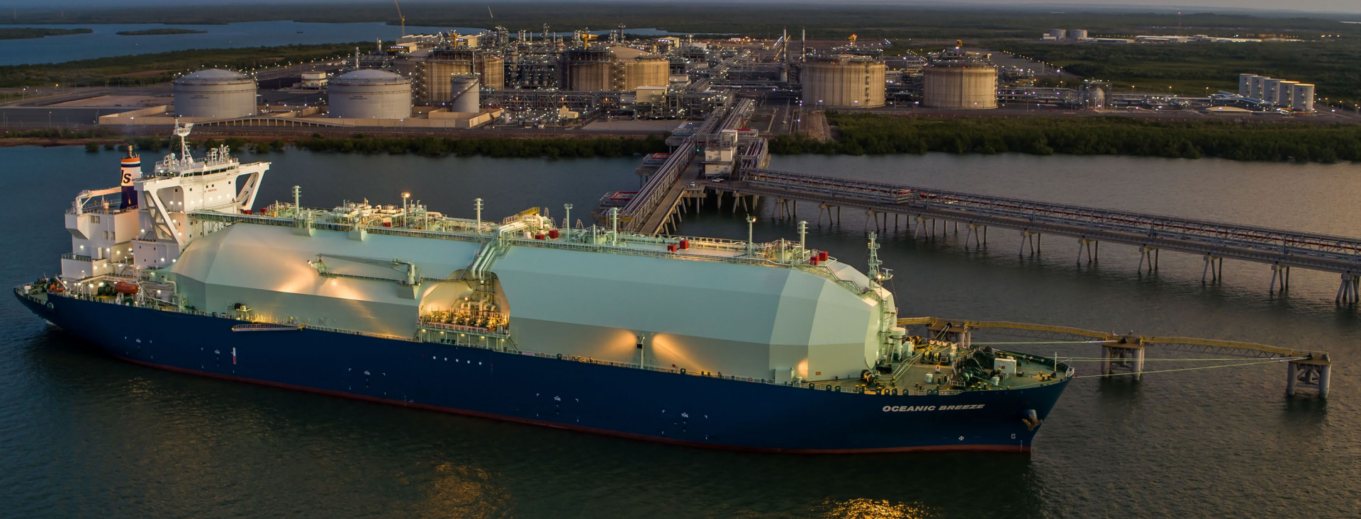
Onshore LNG facility and LNG vessel
