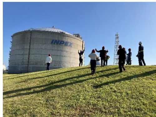
(Tour of the LNG Tank)
