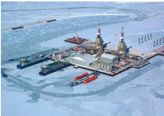
北カスピ海沖合鉦区 海上生産施設
