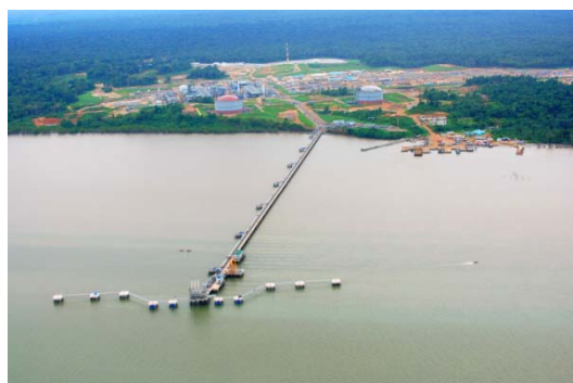
タンゲーLNG基地
