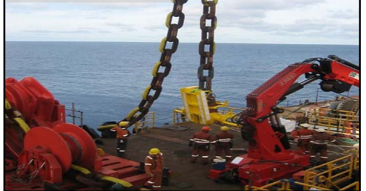
CPF/FPSO用係留チェーンの設置完了(2016年4月、イクシスフィールド)
