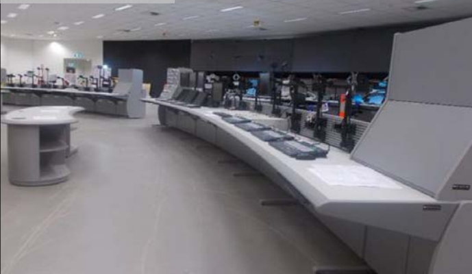
操業管理施設の建設作業(2016年4月、ダーウィン)
