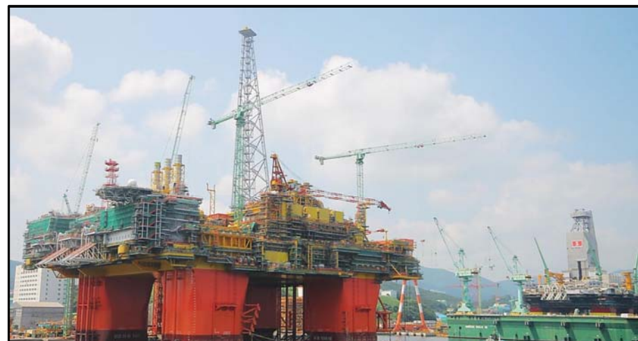
沖合生産・処理施設(CPF)建造の様子(2016年8月)
