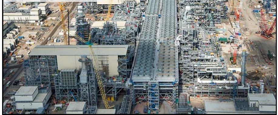
LNGトレインの建設 (2016年8月)
