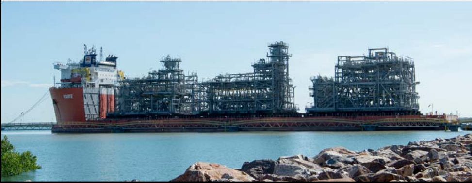
最後の陸上施設用モジュールの搬入完了 (2016年8月)
