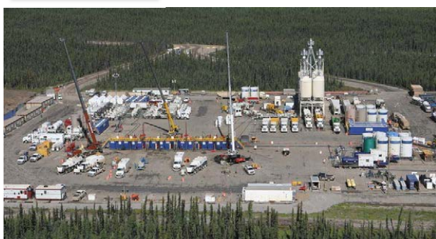
フラクチャリング作業現場
