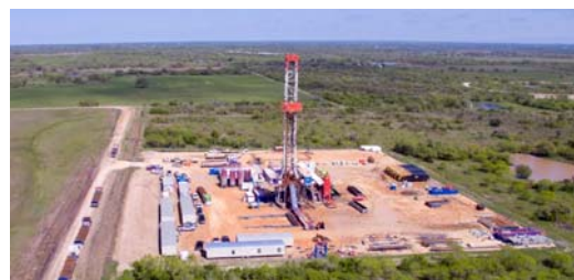
掘削作業現場
