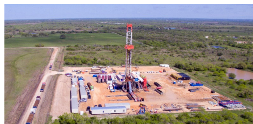
掘削作業現場
