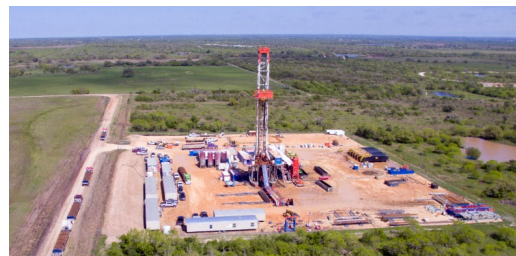
掘削作業現場
