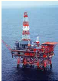
磐城沖ガス田 プラットフォーム
