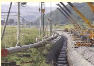
松本ライン建設工事
